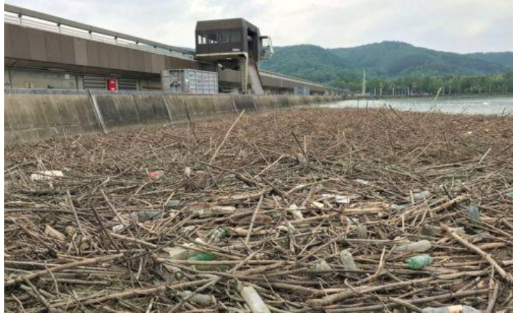
Abbildung 44: Angeschwemmtes Treibgut und Müll beim Donaukraftwerk Greifenstein – nach einem Hochwasserereignis (Quelle: © VERBUND)
