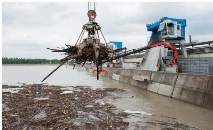
Abbildung 45: Rechengut beim Kraftwerk Altenwörth, welches mit der Rechenreinigungsmaschine bzw. Greifer geborgen wird (Quelle: © VERBUND 132 )
